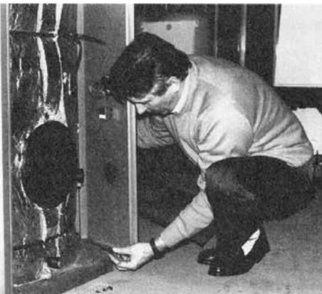
**7** Fixer les quatres panneaux de coin à l'aide des boulons en veillant à empêcher les coins de basculer vers l'arrière. Le panneau muni des appareils de contrôle doit se trouver à l'avant de l'appareil.
