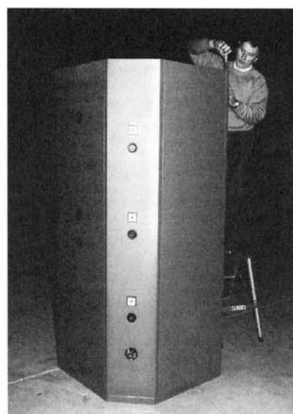
**11** Fixer à l'aide de vis les panneaux latéraux et serrer les vis des coins après avoir convenablement ajusté les panneaux.
