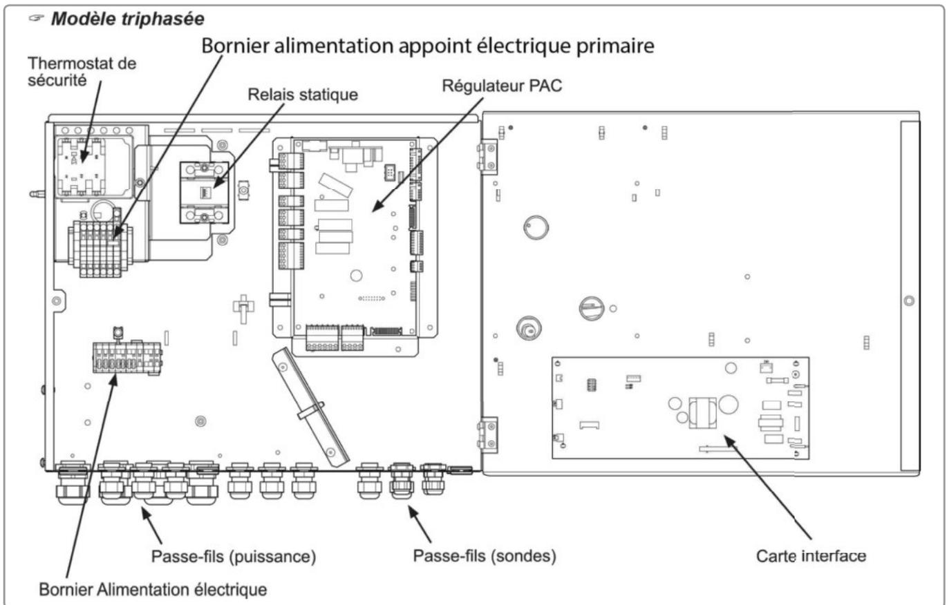
figure 33 - Descriptif du coffret électrique du module hydraulique
