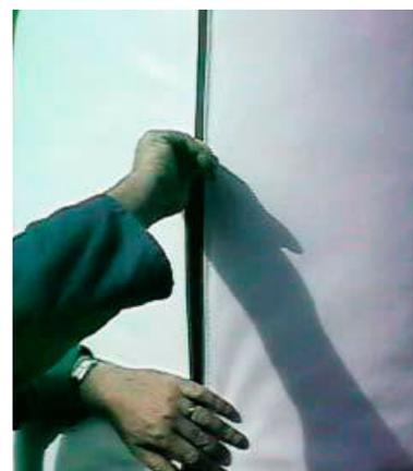
2. Atamos el cordel inferior del aislamiento y nos aseguramos que más o menos esté situado en el centro de la circunferencia Y comprobamos que el aislamiento esté repartido de una manera homogénea a lo largo del perímetro del acumulador.
