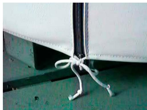
3. A continuación iremos palpando por el aislamiento hasta encontrar una toma. Se recomienda usar la noticia técnica como guía de la ubicación de todas las conexiones. Una vez localicemos una, mediante una maza golpeamos el aislamiento contra la conexión para que está quede marcada en el forro.
